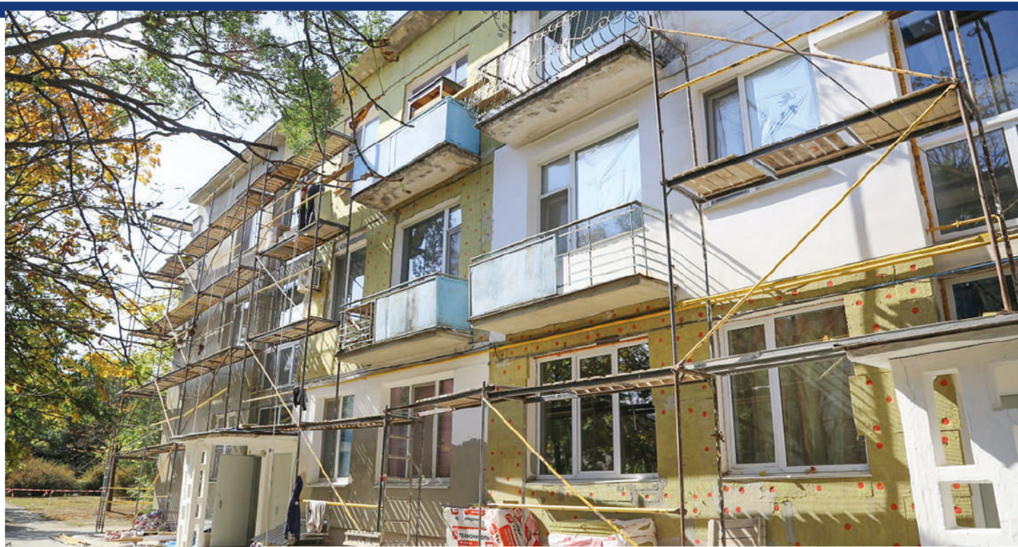
Капремонт многоквартирных домов, который активно ведётся в Крыму, также имеет своей целью защиту жилфонда от разрушения и получения статуса аварийного. Фото: архив «Крымской газеты»
