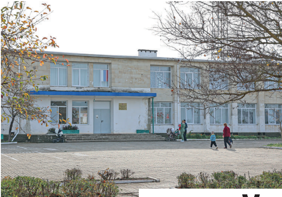
В Доме культуры заменили окна, но капремонта пока ждать не приходится.
