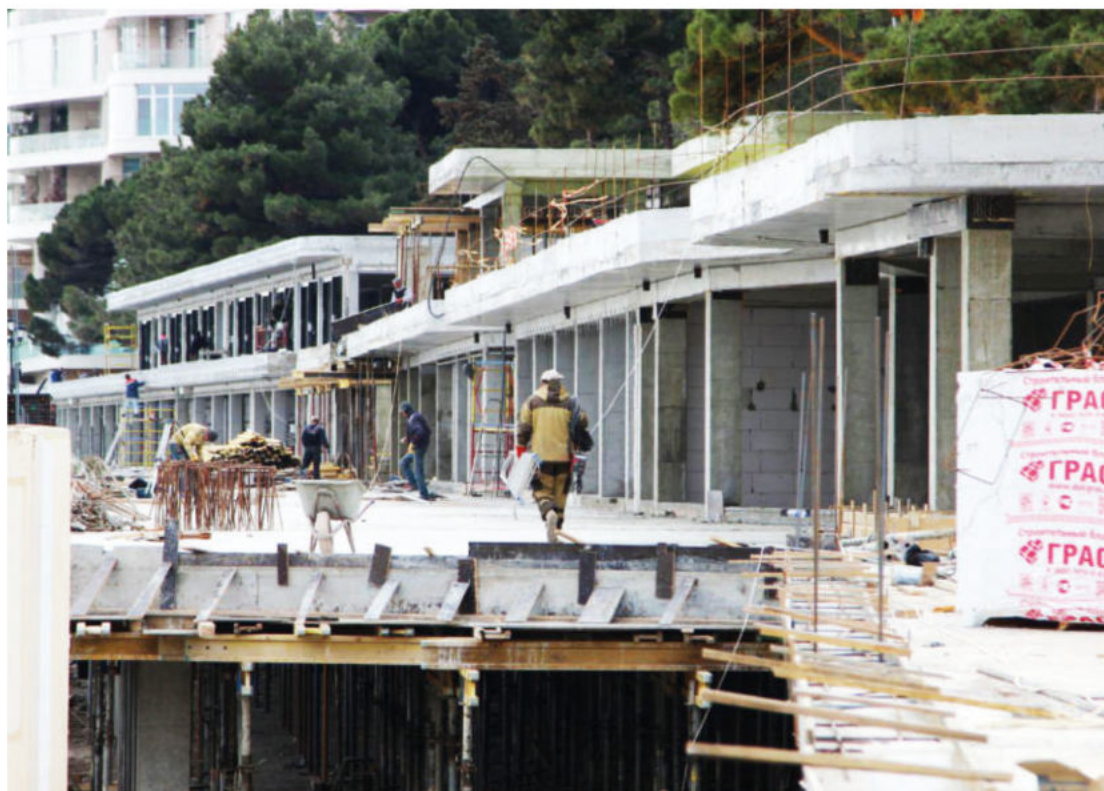
Ялта. Реконструкция Приморского пляжа. Здесь будет новая видовая площадка. Строительство ведётся за внебюджетные деньги. Фото: Михаил ГЛАДЧУК
