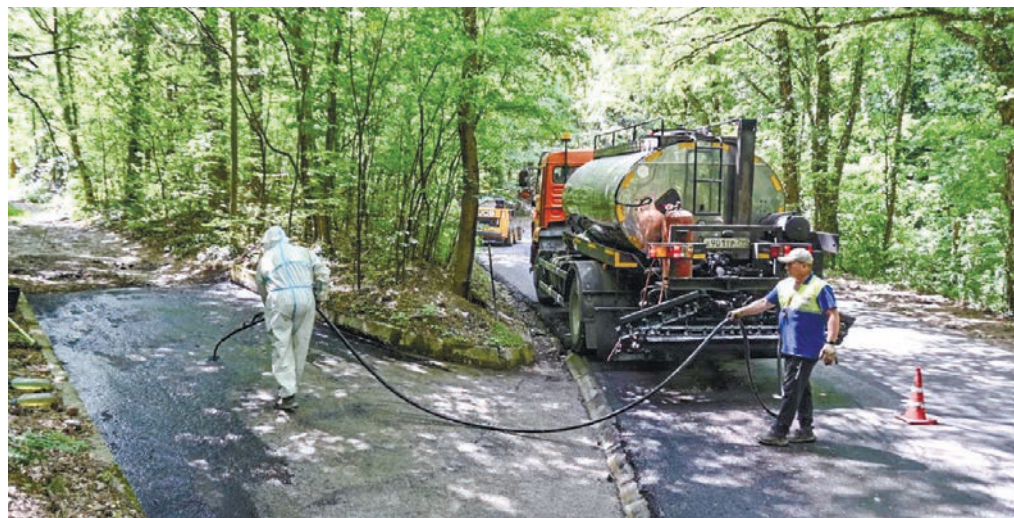
Перед укладкой нового асфальта съезд обрабатывают битумной эмульсией.
