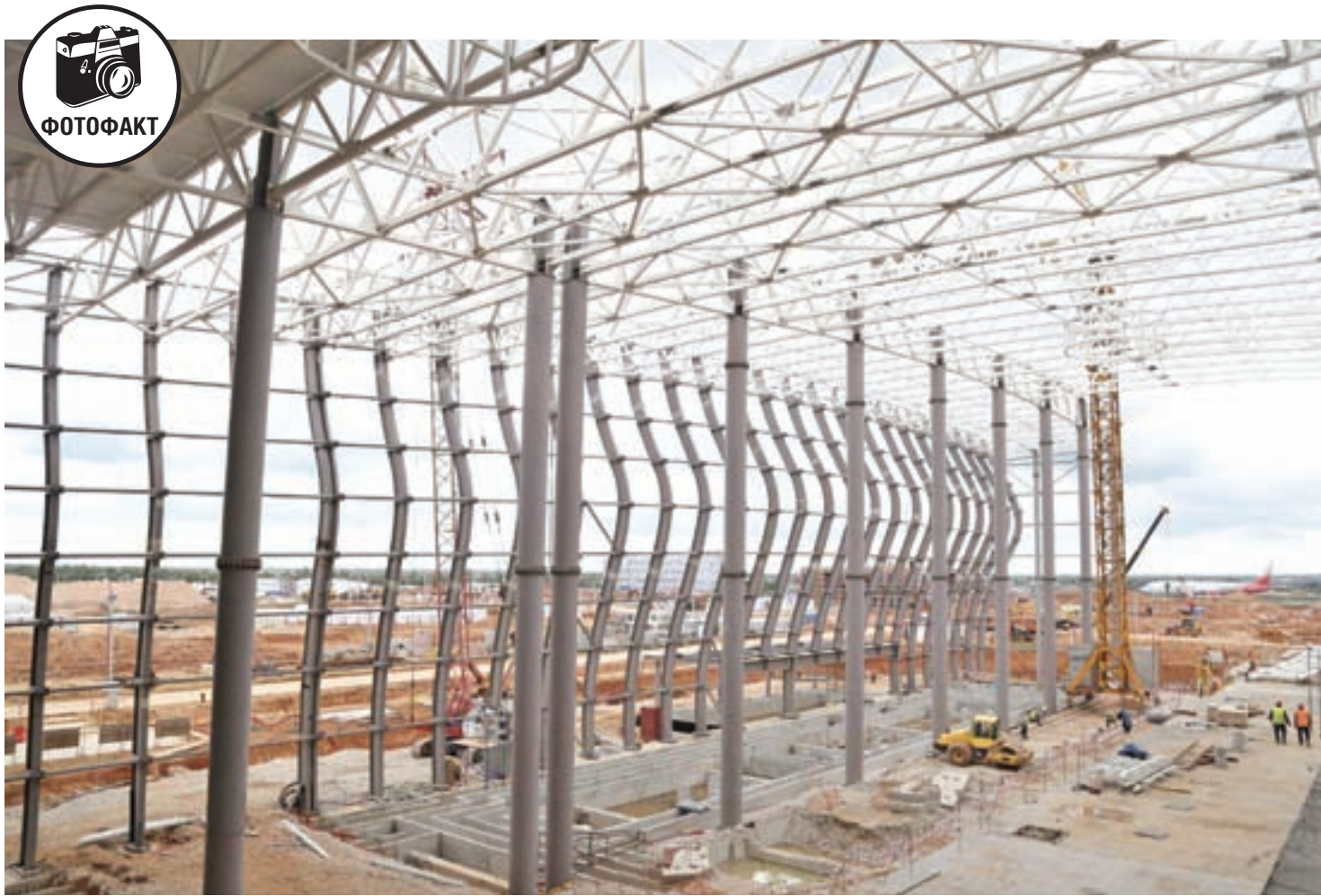
Строители нового терминала аэропорта Симферополь начали прокладку инженерных сетей. Фото: Владимир ПРОШКИН. Фоторепортаж смотрите на сайте «Крымской газеты» gazetacrimea.ru
