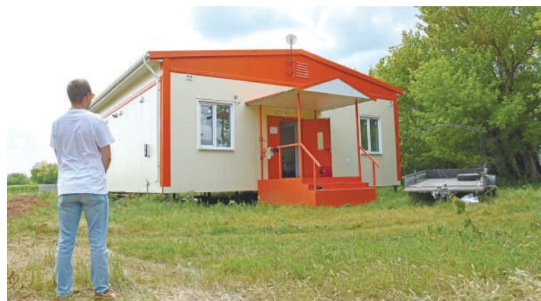
Быстрым темпом идёт строительство ФАПа.
