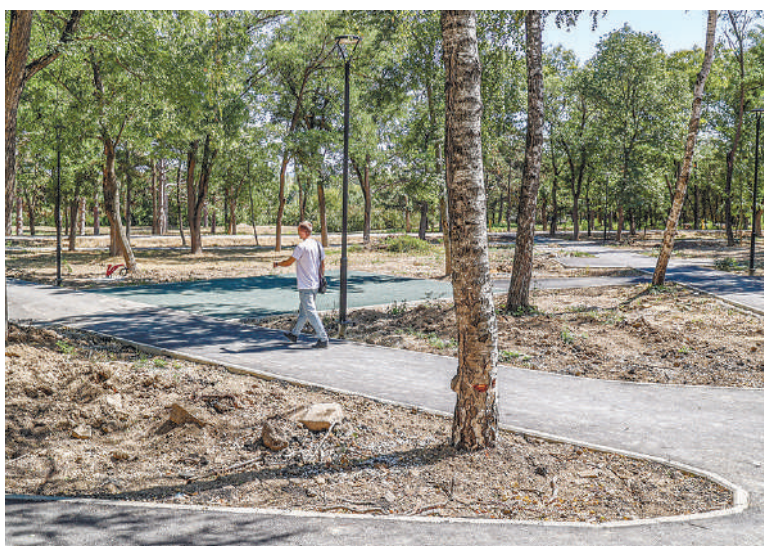
Сейчас идёт капитальный ремонт и благоустройство парка.
