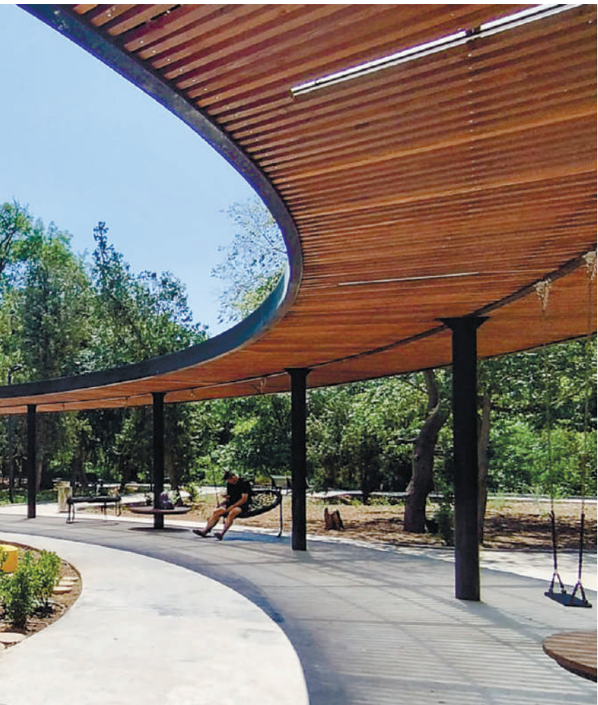
Так выглядит сакский Курортный парк, который в 2022–2023 годах прошёл основные этапы благоустройства. Впереди – восстановление системы прудов и Лебединого озера. Ожидается, что весь комплекс работ завершится после 2027 года.
