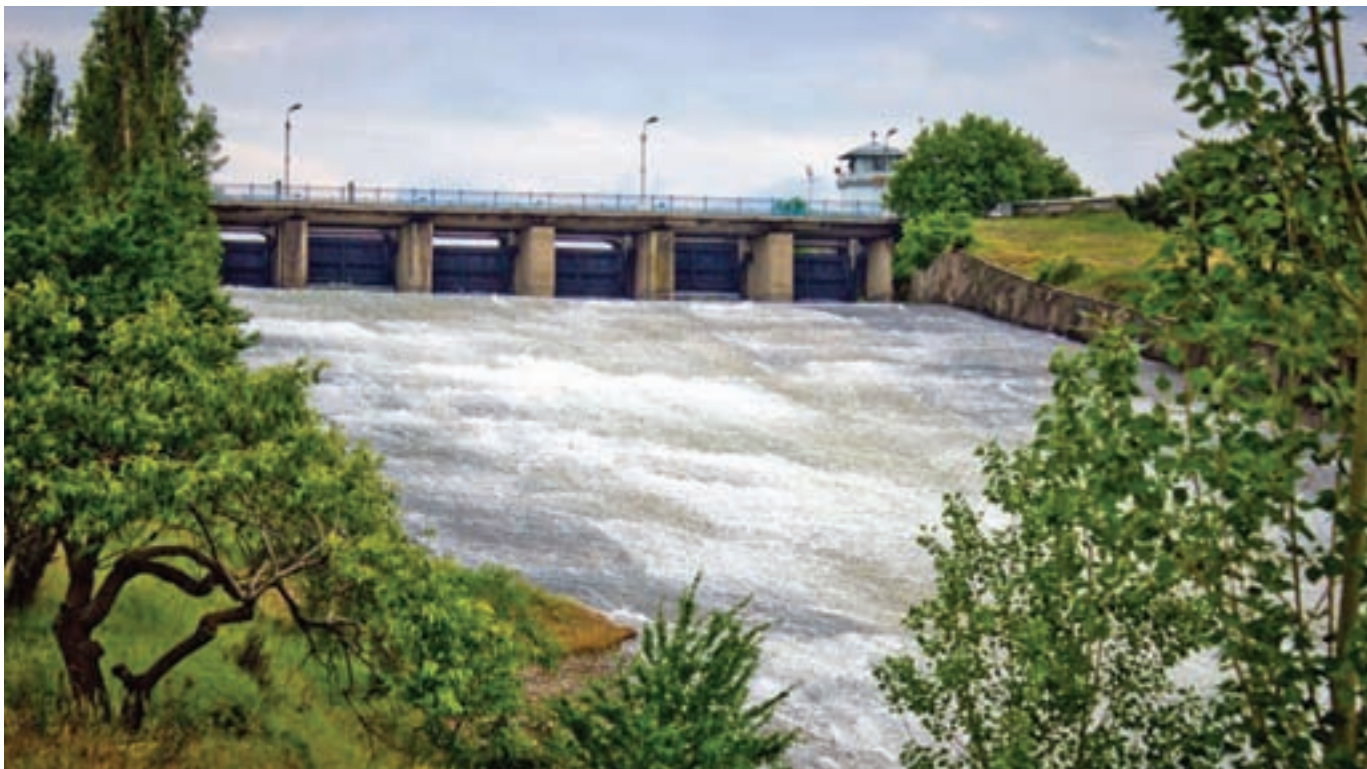
Сброс воды из Симфе- ропольского водохрани- лища. Фото: my-simf.ru
