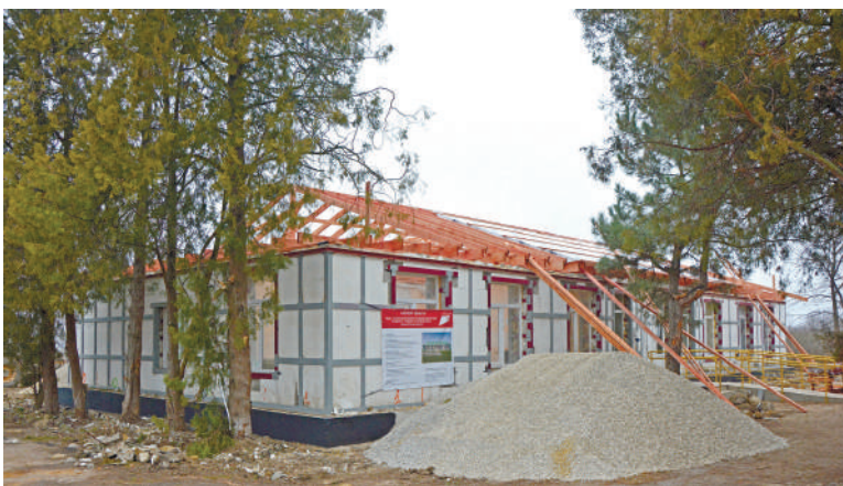
Активно идёт строительство ФАПа.
