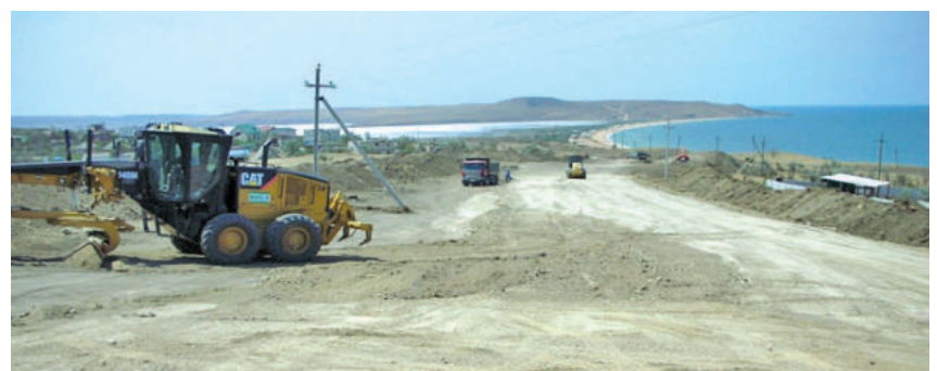
Строительство новой дороги к озеру Чокрак, Керченский полуостров. Фото: rk.gov.ru
