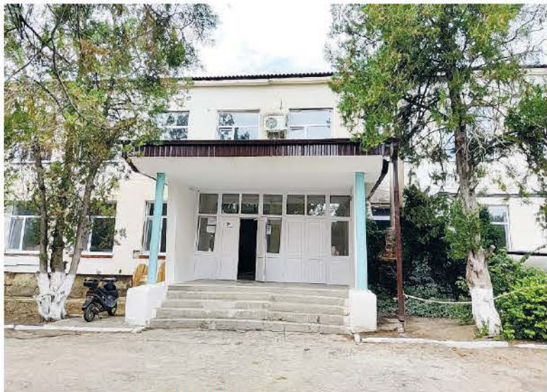
Ремонт школы подходит к концу.
