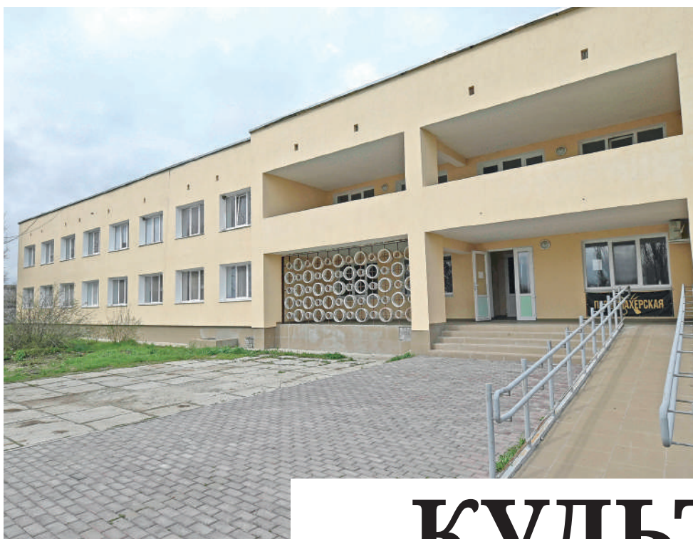
Произведён капитальный ремонт общежития.
