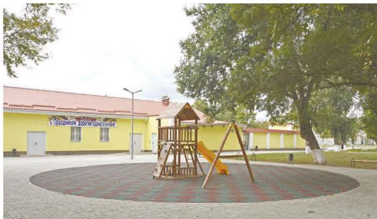
Дом культуры после ремонта выглядит по-новому.
