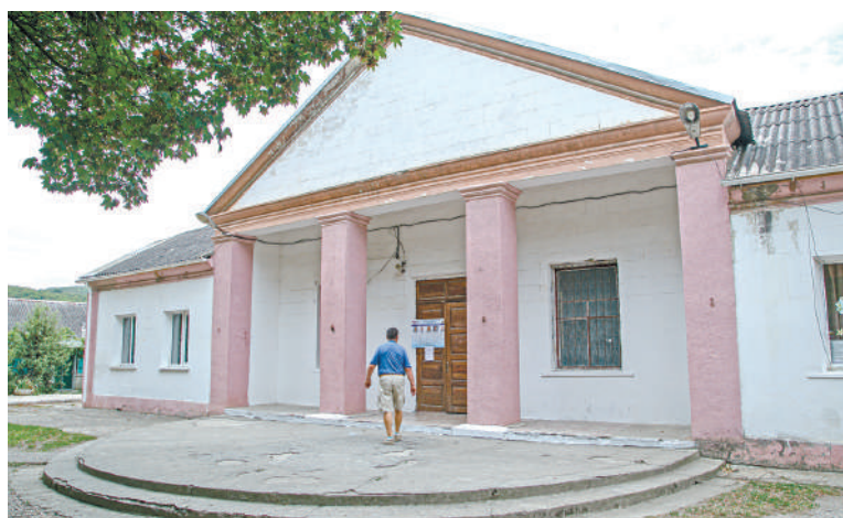
Сотрудники и посетители ДК терпеливо ждут ремонта здания.
