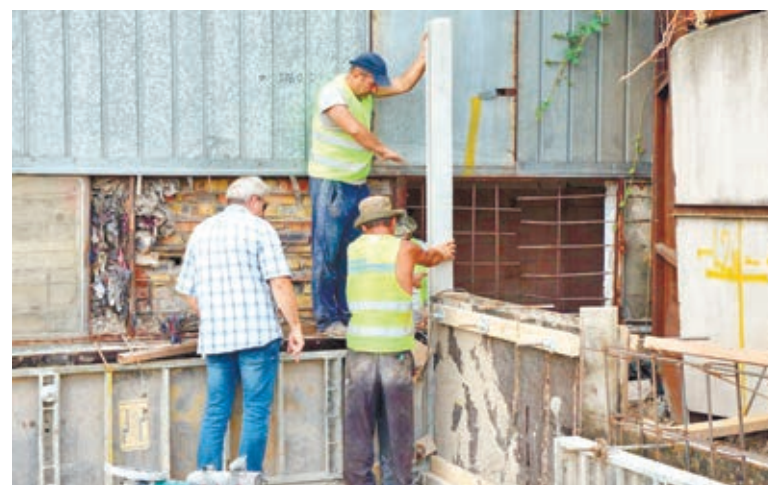
Строительство приюта идёт полным ходом. Фото: simadm.ru
