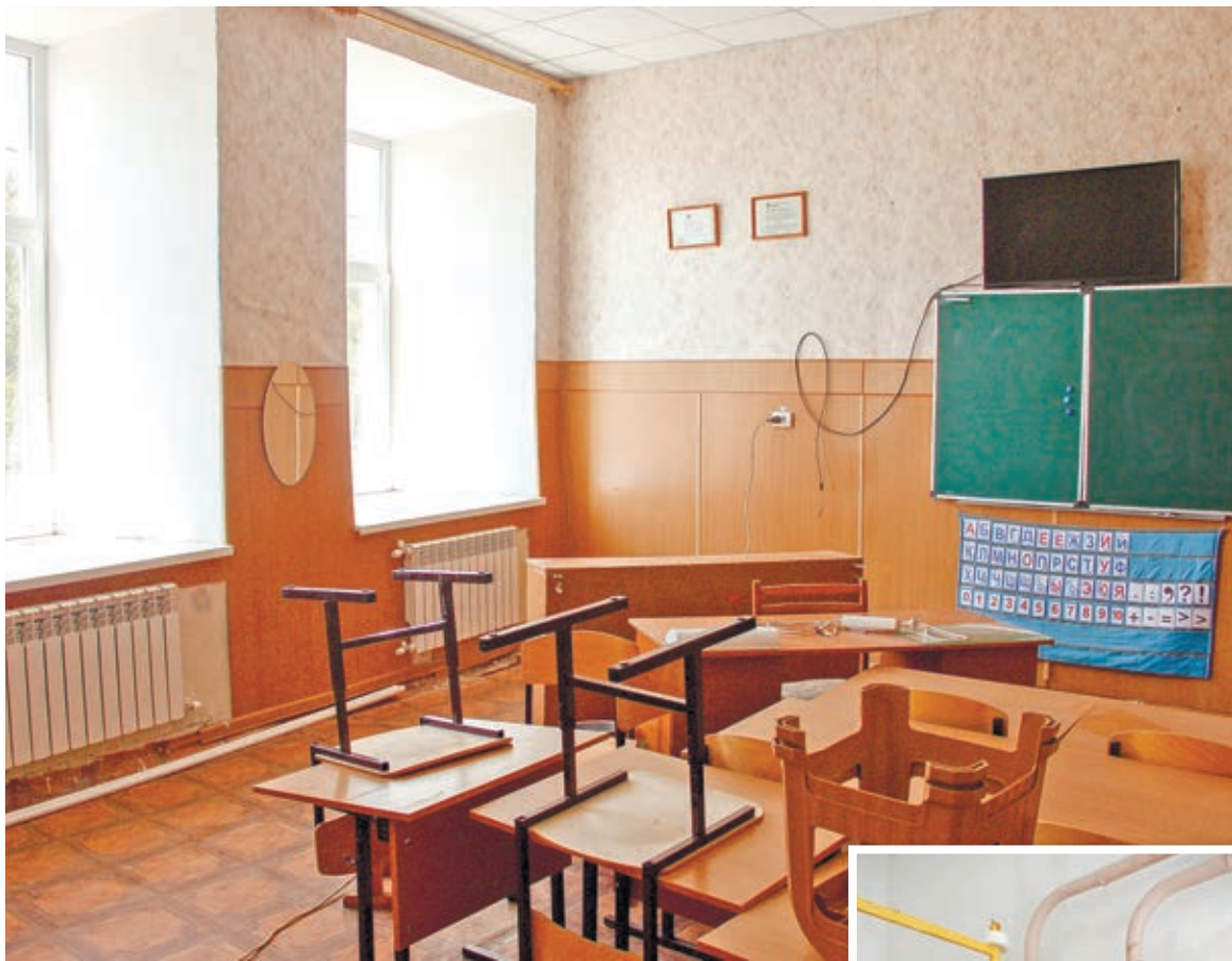
Замены устаревшей системы отопления «Злагода» ждала десятки лет.
