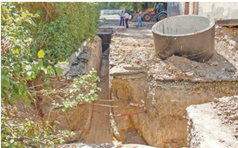
Капитальный ремонт канализации и кровли школы № 21 подходит к концу.
