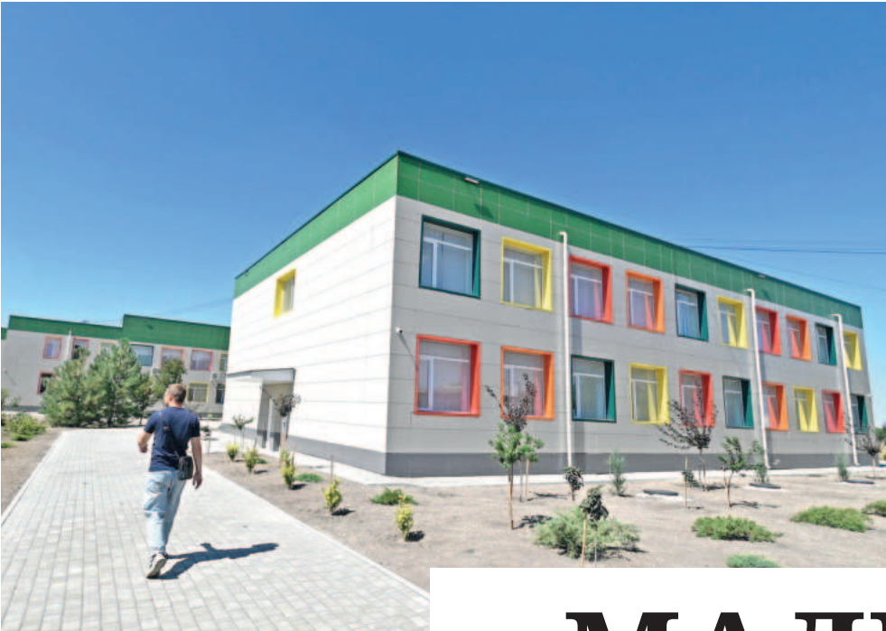
Год назад в школе завершился капитальный ремонт.
