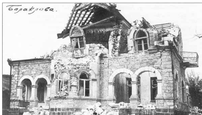
Дом в Балаклаве, разрушенный землетрясением. Фото: krimoved-library.ru
