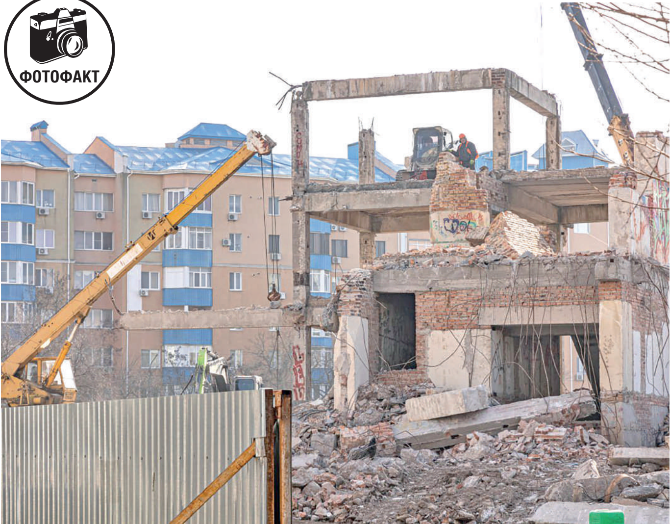
11 февраля, Евпатория. Работы по сносу Дворца пионеров, заброшенного недостроя советских времён. Фото Михаила ГЛАДЧУКА.
