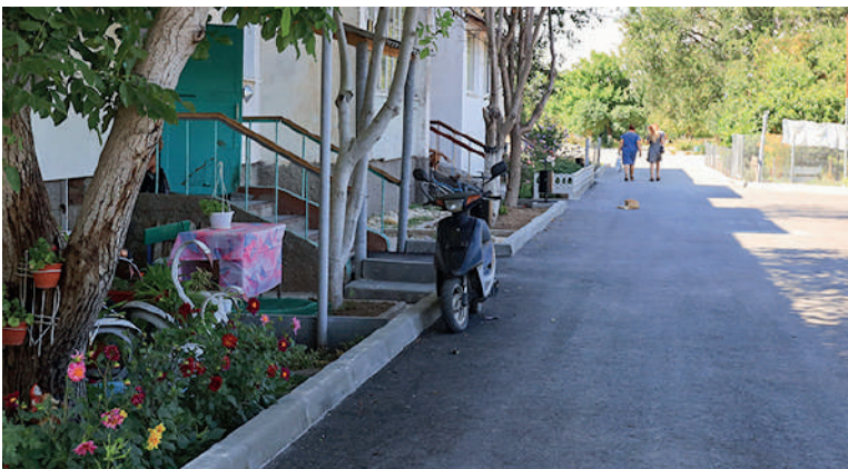
Подъездные пути на улице Дубинина заасфальтированы.
