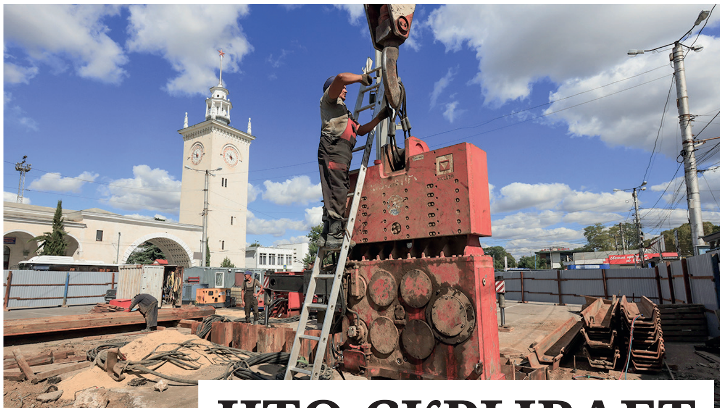
Завершить строительство коллектора в Симферополе планируют в 2023 году. Фото: Наталья СОМОВА
