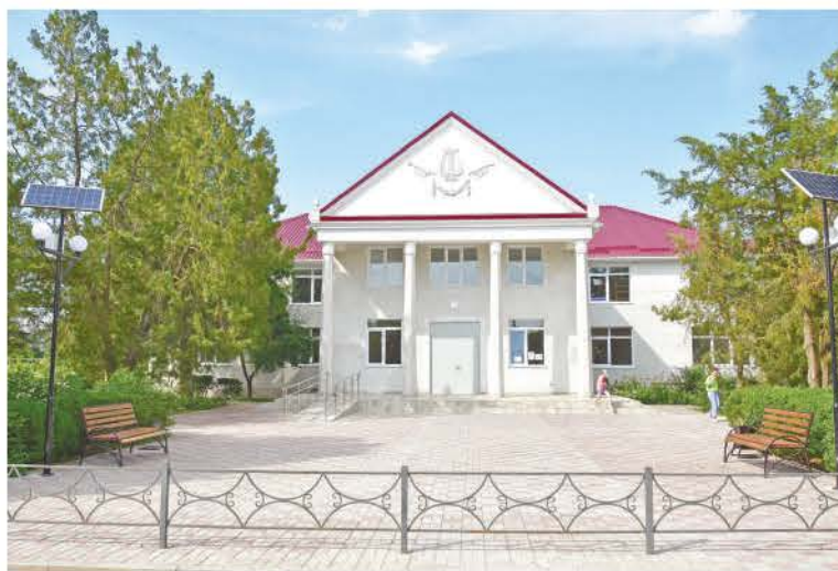
В отремонтированном Доме культуры постоянно много посетителей.
