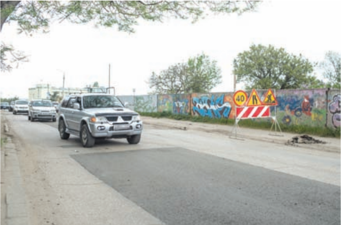
На прошлой неделе на улице Авиационной начали ямочный ремонт. Асфальт будут стелить так называемыми картами ещё на 81 улице города.
