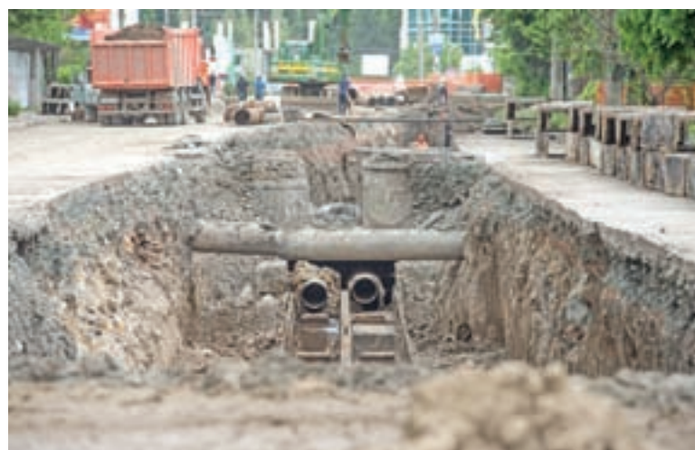
Улица Толстого. Здесь идёт замена инженерных коммуникаций. По окончании работ дорогу приведут в надлежащий вид.
