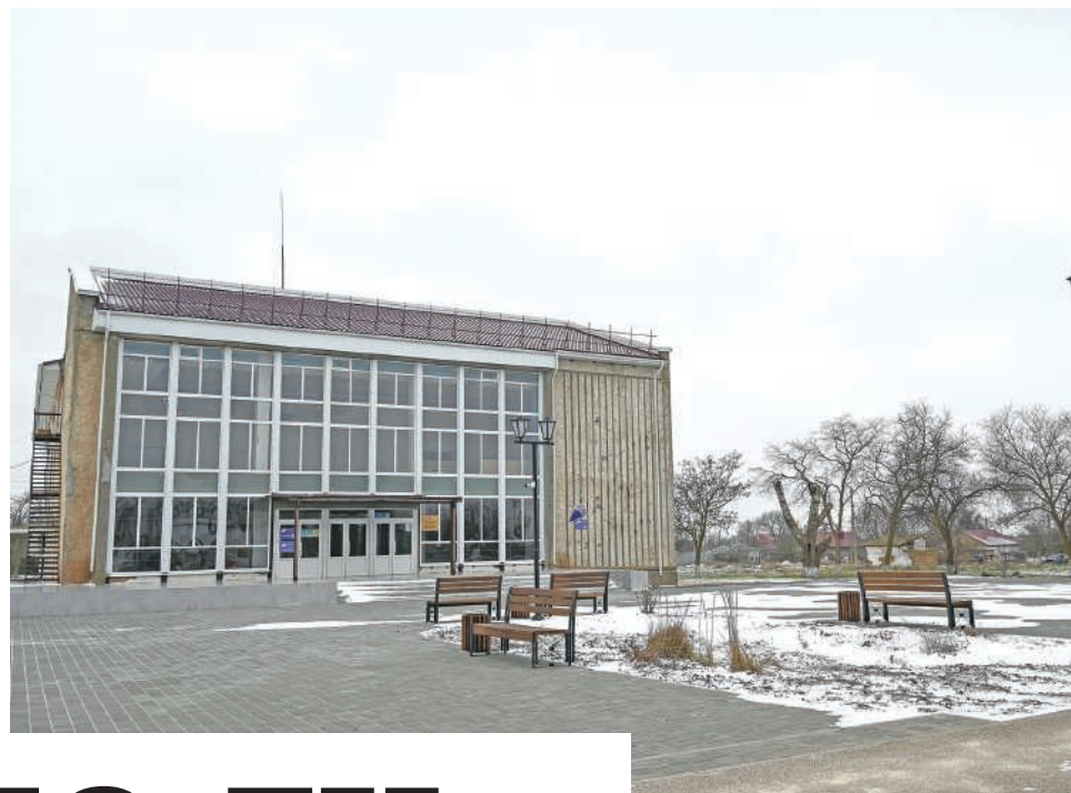
Дом культуры отремонтировали, а площадь перед ним благоустроили.
