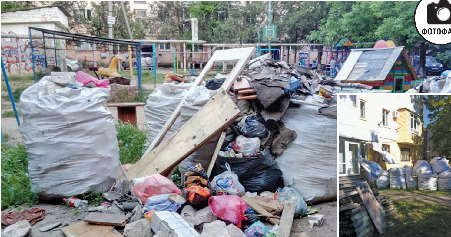
Этот строительный мусор, который остался после ремонта кровли в симферопольском дворе на ул. Киевской, 138, лежит с марта. Такая же ситуация (на фото справа) и во дворе на ул. Киевской, 82. Фото из соцсетей
