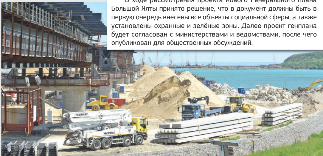
Строительство автомобильного подхода к Крымскому мосту. Фото Антон ВОЛК.
