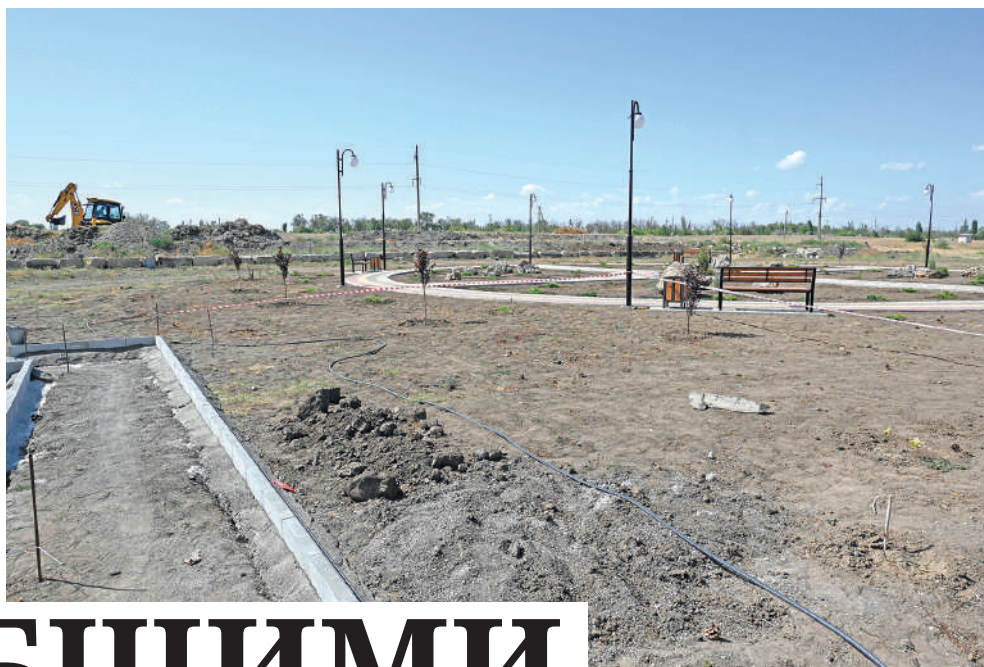
Работы по расширению и обустройству парка продолжаются и сегодня.
