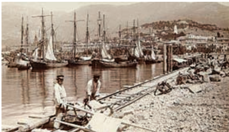
Строительство мола. 1890 г. old-photo.gallery
