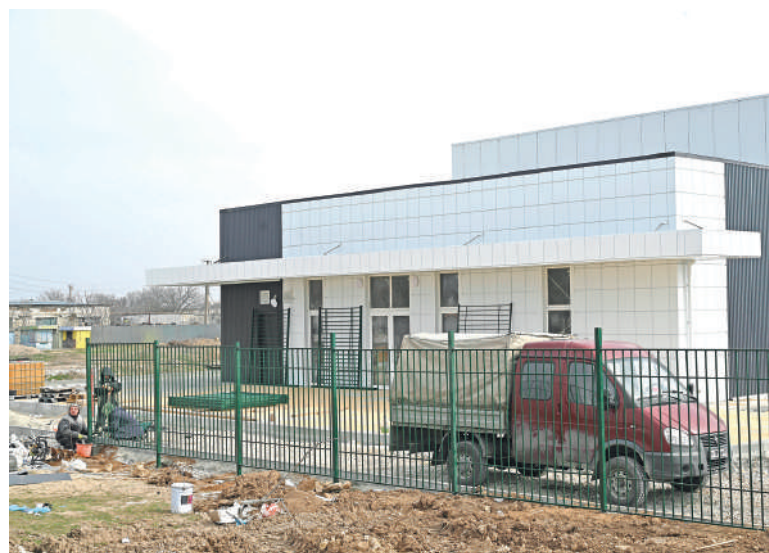
Строительство ФОКа вышло на финальную стадию.
