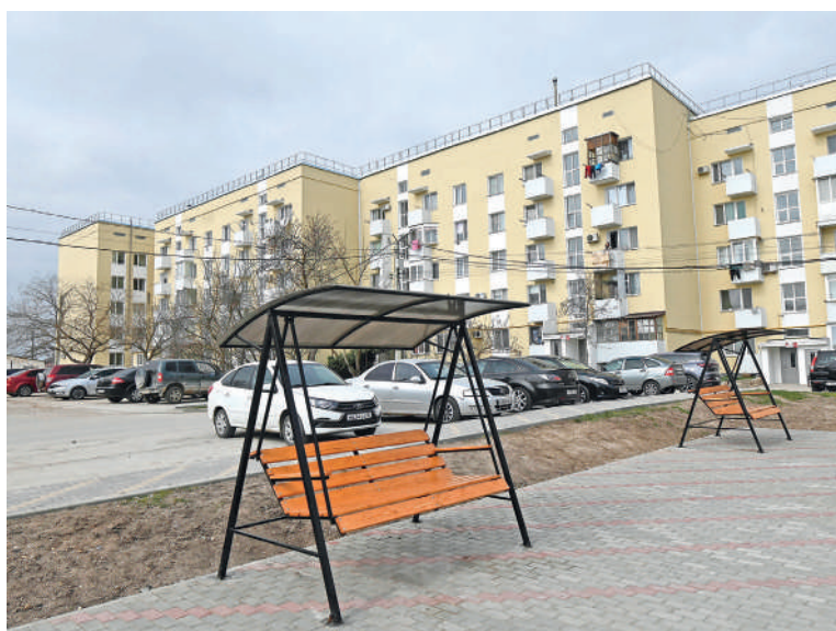
Большая часть придомовых территорий в посёлке уже обновлена.
