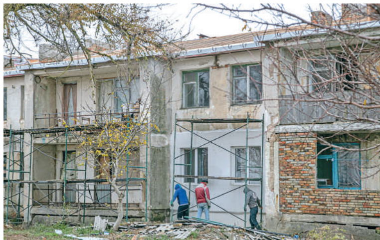
Рабочие выполняют замену крыши в одном из многоквартирных домов.
