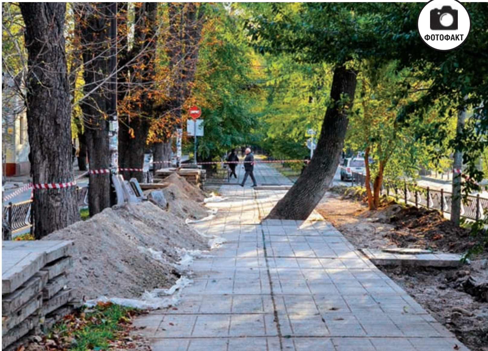
Реконструкция пешеходной зоны на бульваре Франко в Симферополе. Фото: Владимир ПРОШКИН
