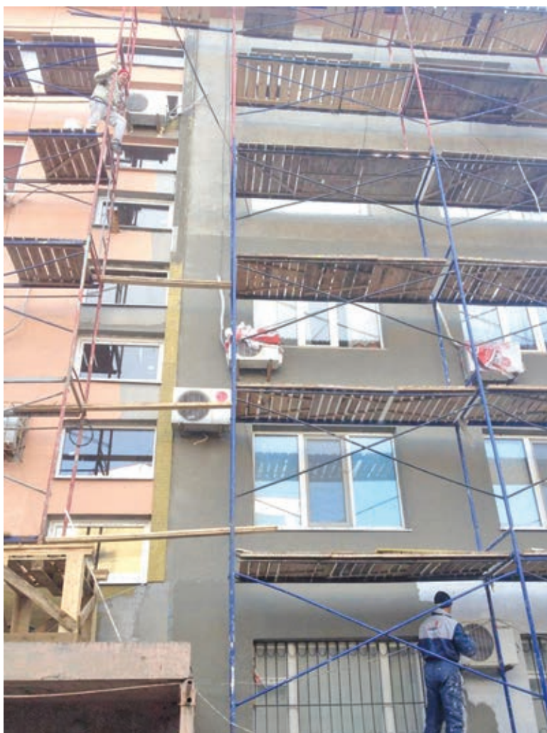
Капремонт многоквартирного дома: Судак, ул. Бирюзова, 58.
