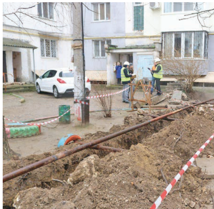
ГУП РК «Крымтеплокоммунэнерго» ведёт работы по реконструкции теплотрассы на улице Лебедева, доставляла много хлопот как коммунальным службам, так и простым жителям.
