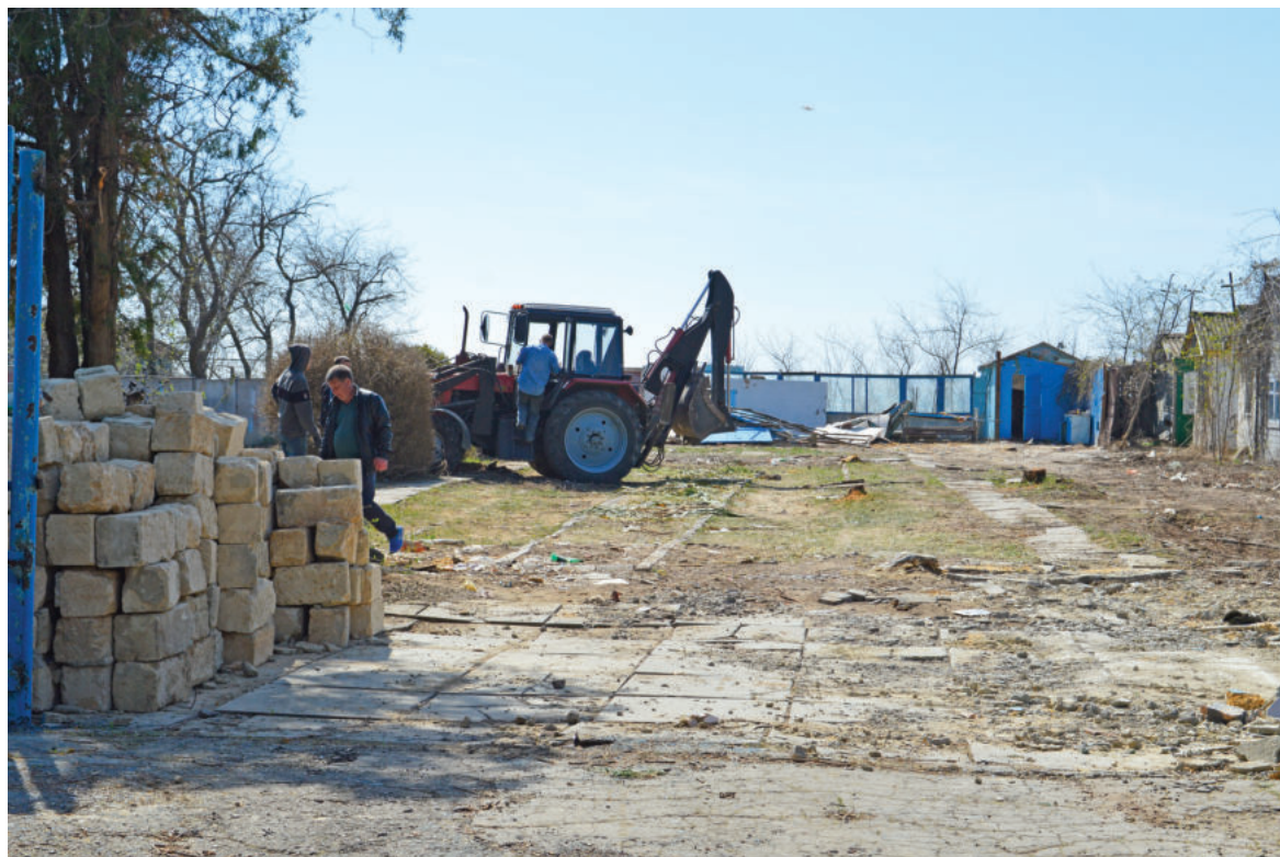
Практически окончен демонтаж базы отдыха «Крымтроллейбуса». Здесь будет зона общего доступа, свободный проход к пляжу.
