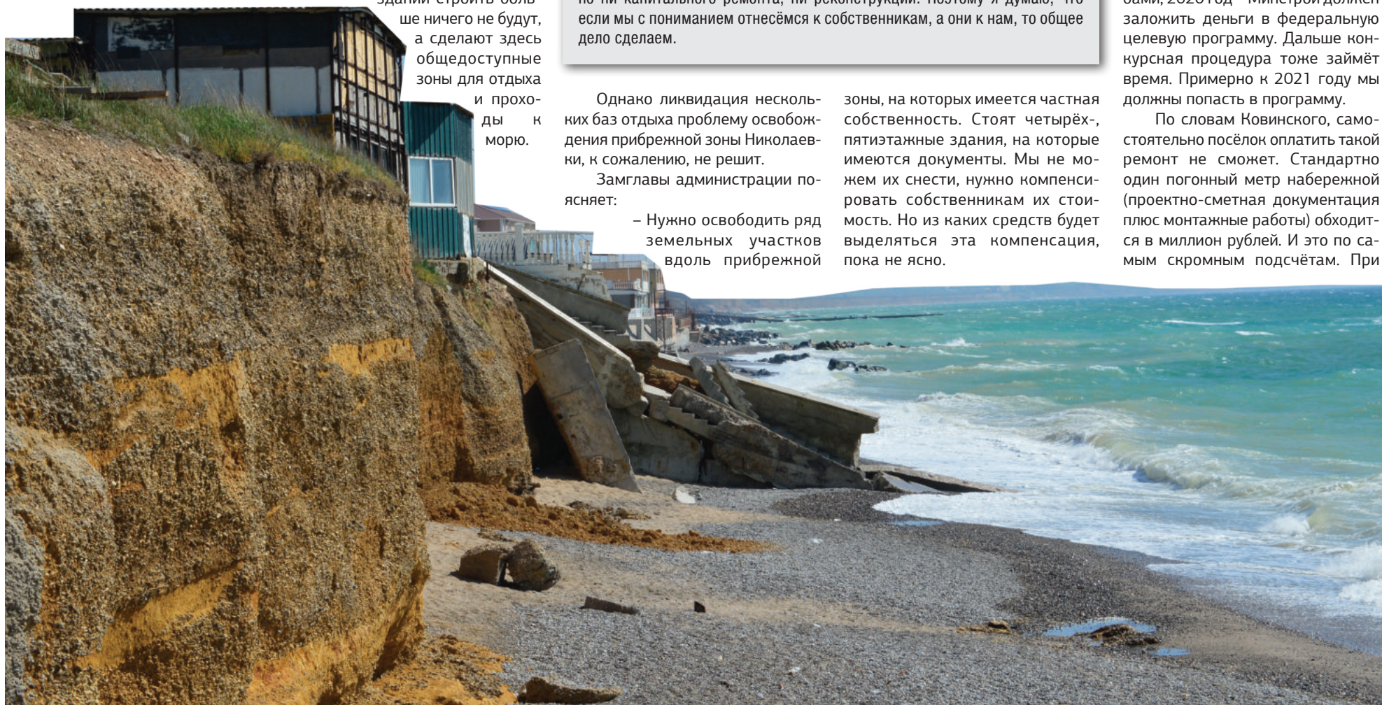
Обрушившуюся лестницу к началу курортного сезона местные власти обещают демонтировать.
