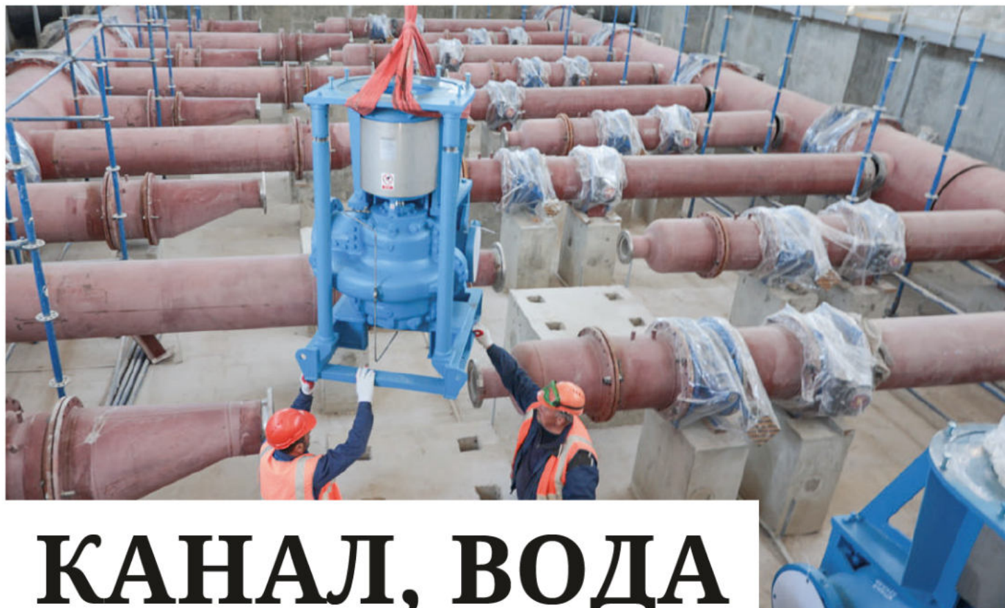
На насосной станции № 1 в машинном зале устанавливают насос. Фото: Наталья СОМОВА
