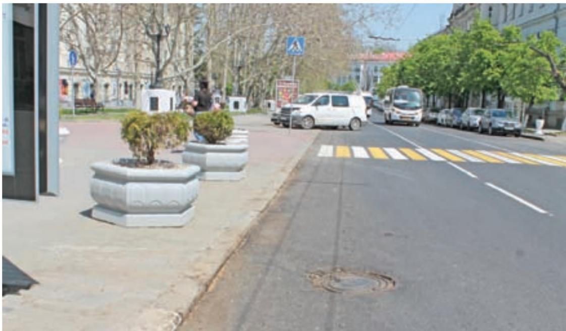
Люки на отремонтированной дороге небрежно утоплены в асфальт...
