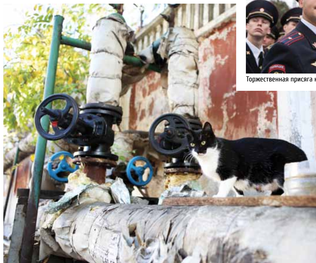
В октябре крымчане с нетерпением ждали тёплых батарей в квартирах. Надеемся, власти, как и обещали, обеспечили теплом жителей всех многоквартирных домов.
