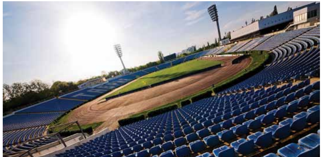
Стадион «Локомотив» начнут ремонтировать в следующем году.
