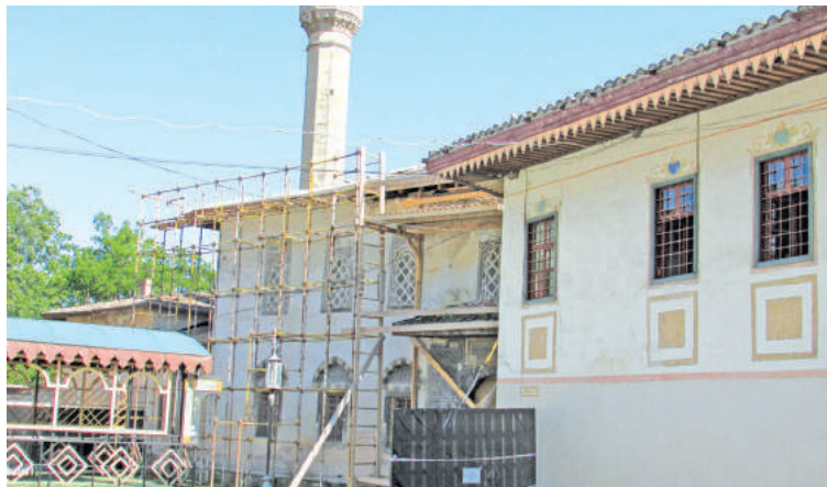
Противоаварийные работы в Ханском дворце.
