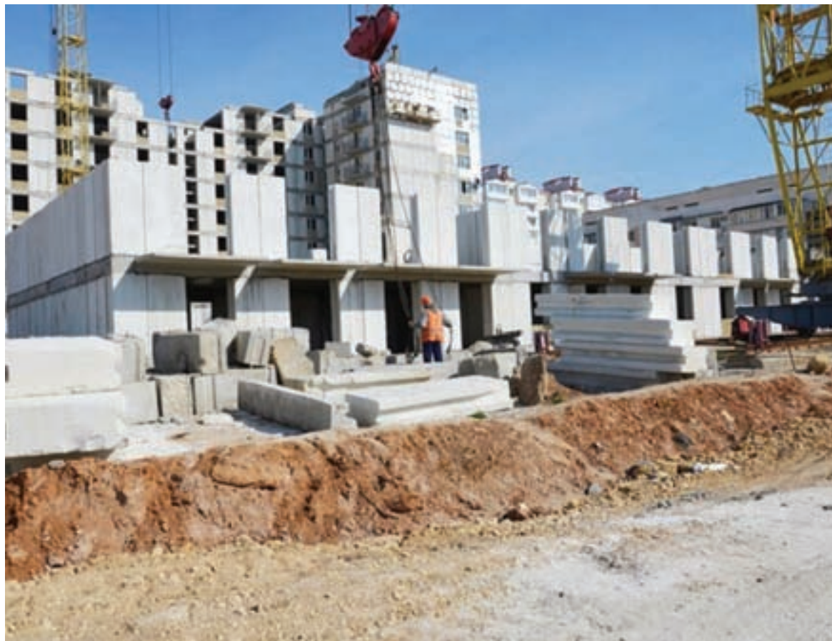
Возведён седьмой этаж девятиэтажного дома в Евпатории, строящегося по программе «Жильё для российской семьи». Фото: my-evp.ru
