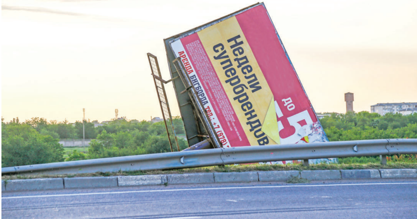
Симферопольская объездная. В Крыму продолжается снос незаконно установленных рекламных конструкций. Фото: Лидия ВЕТХОВА.
