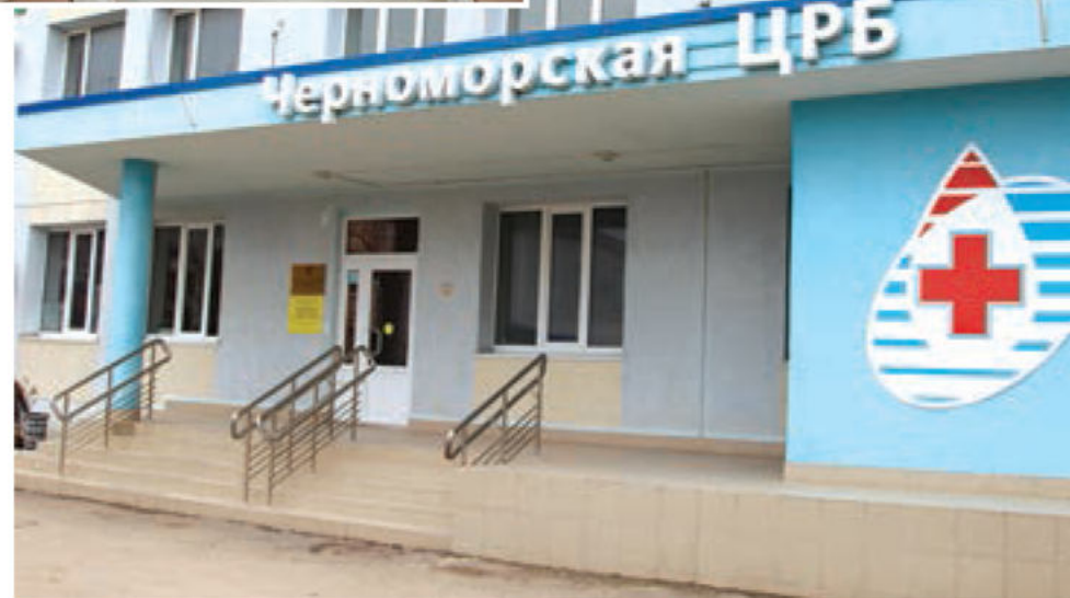
В Черноморской ЦРБ с прошлого года идёт капитальный ремонт. Здание уже выглядит достойно.
