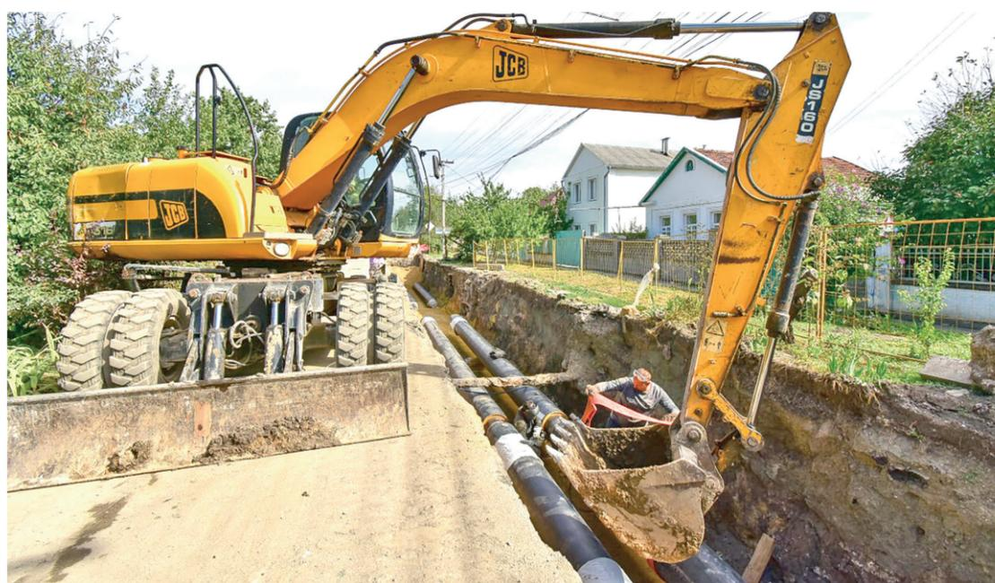
Работы на ул. Сельвинского. Здесь укладывают новый трубопровод теплотрассы протяжённостью почти один километр.
