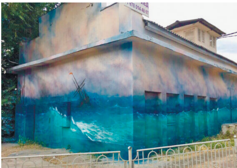
Теплостанция в Симферополе на улице Севастопольской. Произведение проекта «Галерея под небом» – граффити по мотивам картины Айвазовского «Корабль среди бури». Фото из личного архива Владислава Подопригоры
