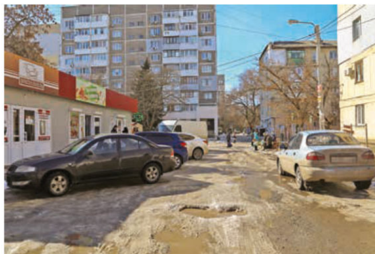
Эту дорогу ремонтировали не так давно, к приезду главы Крыма.
