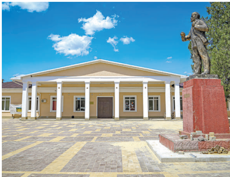
Ремонт площади перед Домом культуры уже на завершающей стадии.
