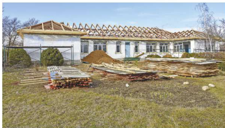
Капремонт амбулатории в разгаре.
