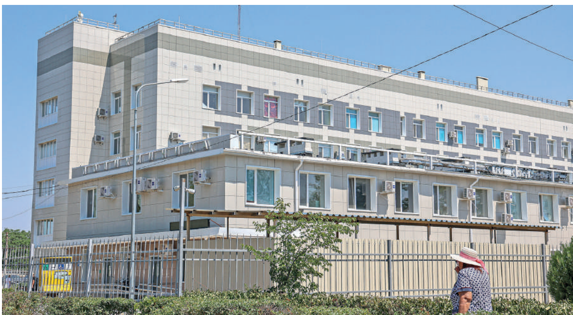
Завершён капитальный ремонт больницы.
