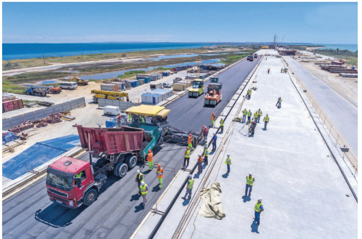
На Крымском мосту начали укладывать асфальт. Фото: Most.life
