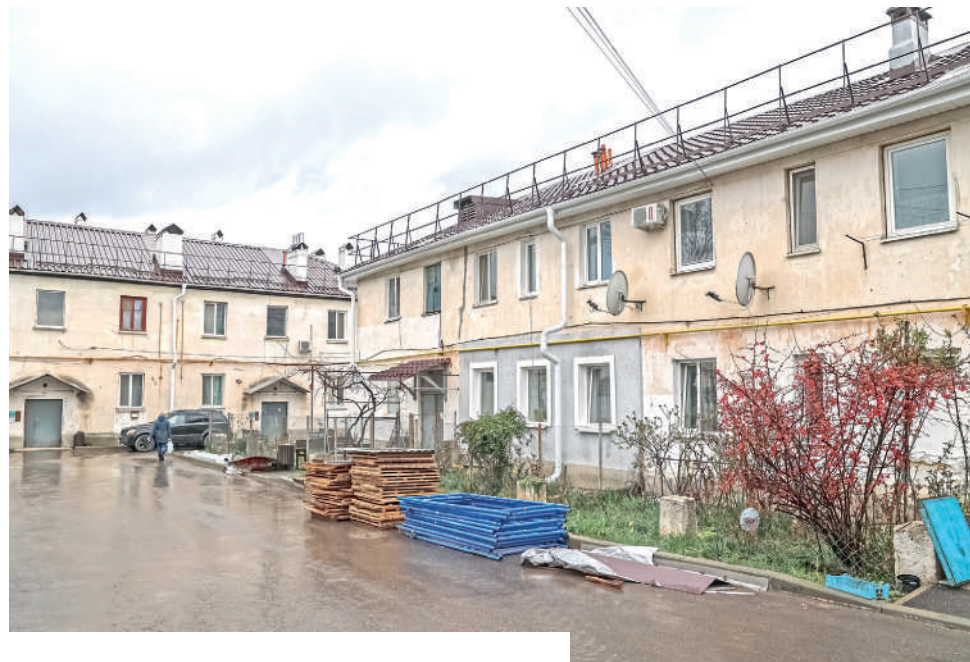
В этом году продолжается ремонт кровель МКД.
