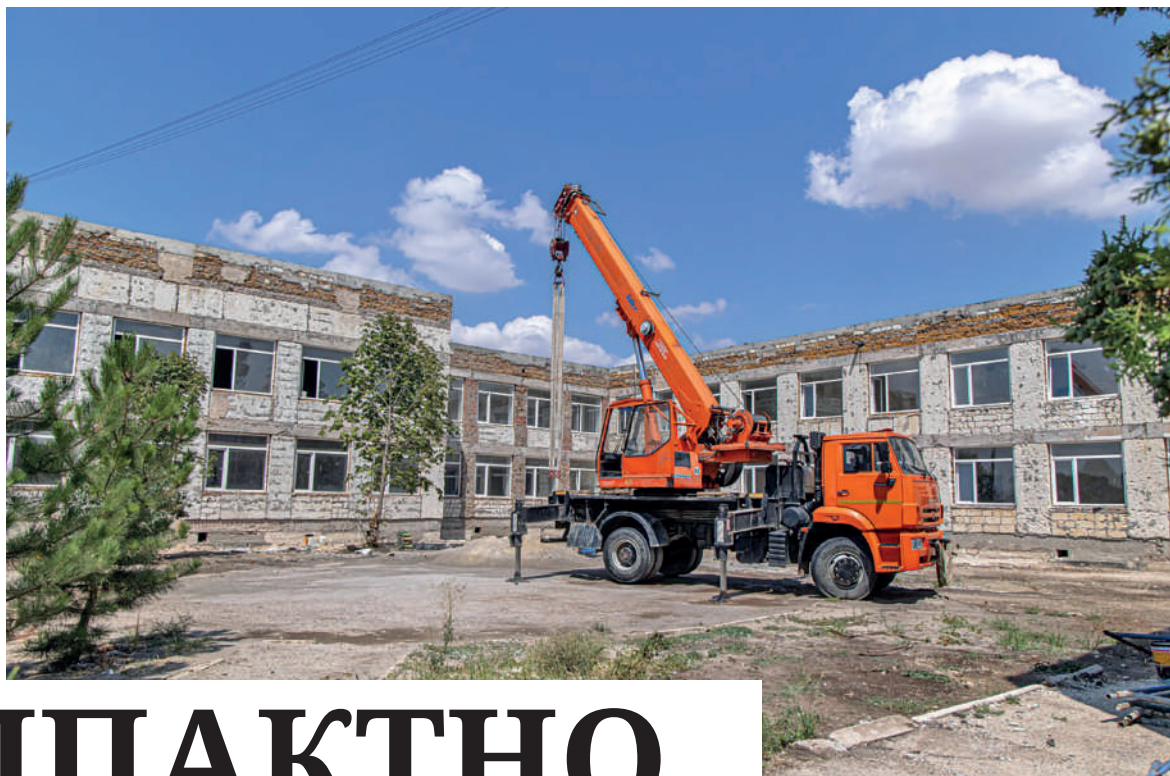
Идёт капитальный ремонт Найдёновской школы.
