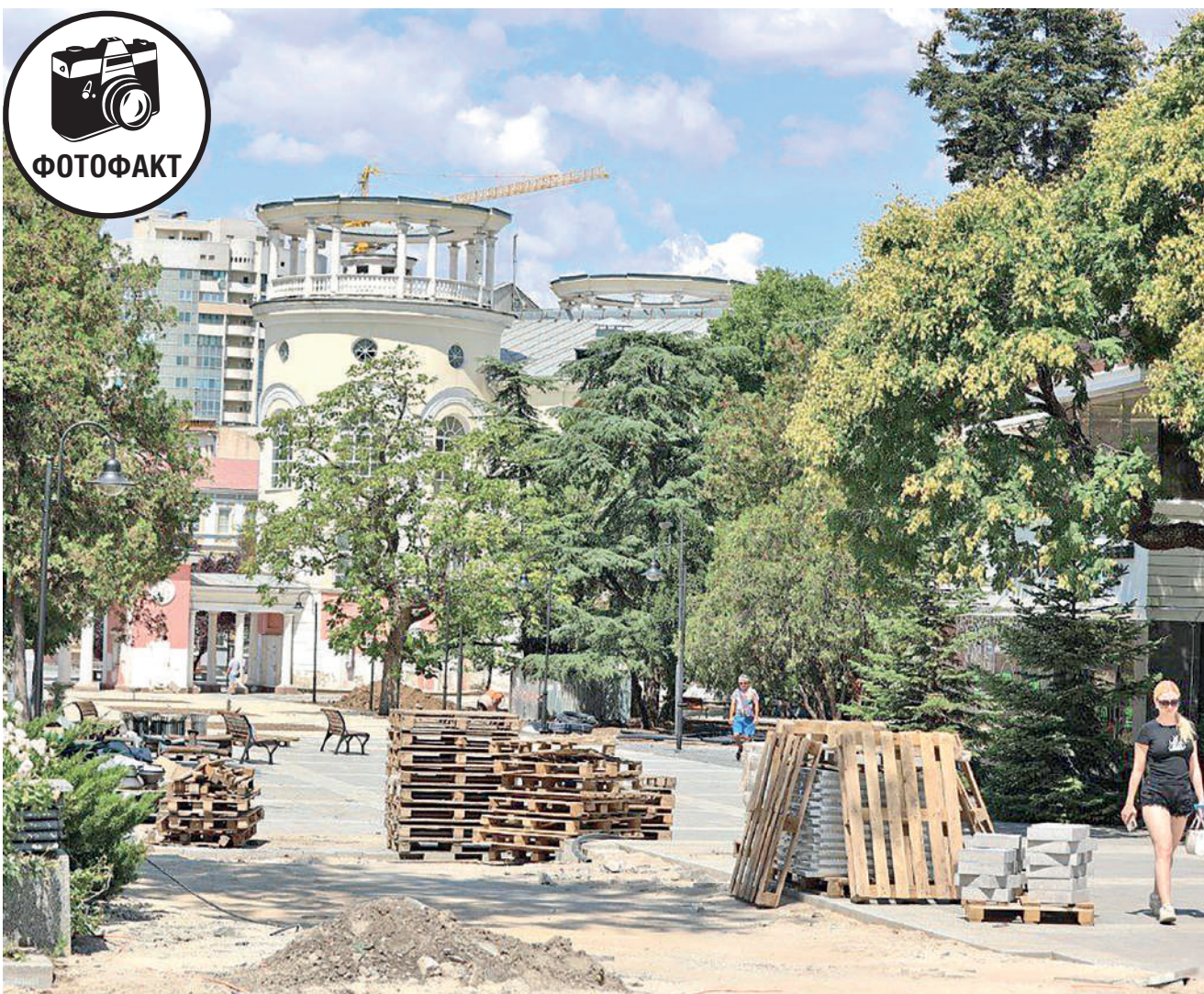
25 июля, Симферополь. В крымской столице продолжается реконструкция Екатерининского сада. Завершить работы планируют до 1 августа. Фото Михаила ГЛАДЧУКА.
