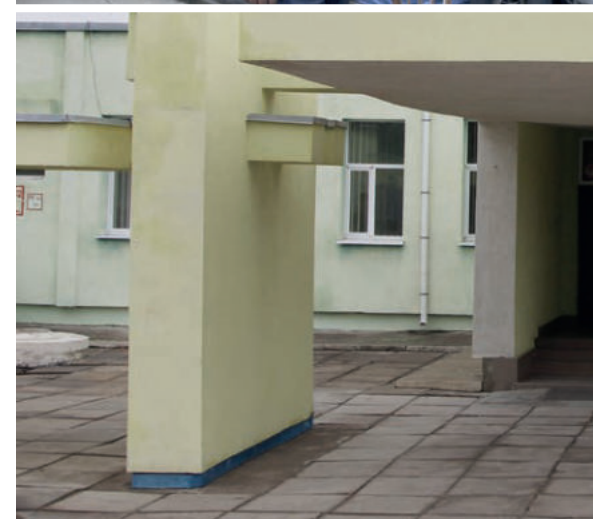
Детская юношеская спортивная школа Армянска, где полностью реконструированы и установлены новые фильтровальные установки и переливные ёмкости.
