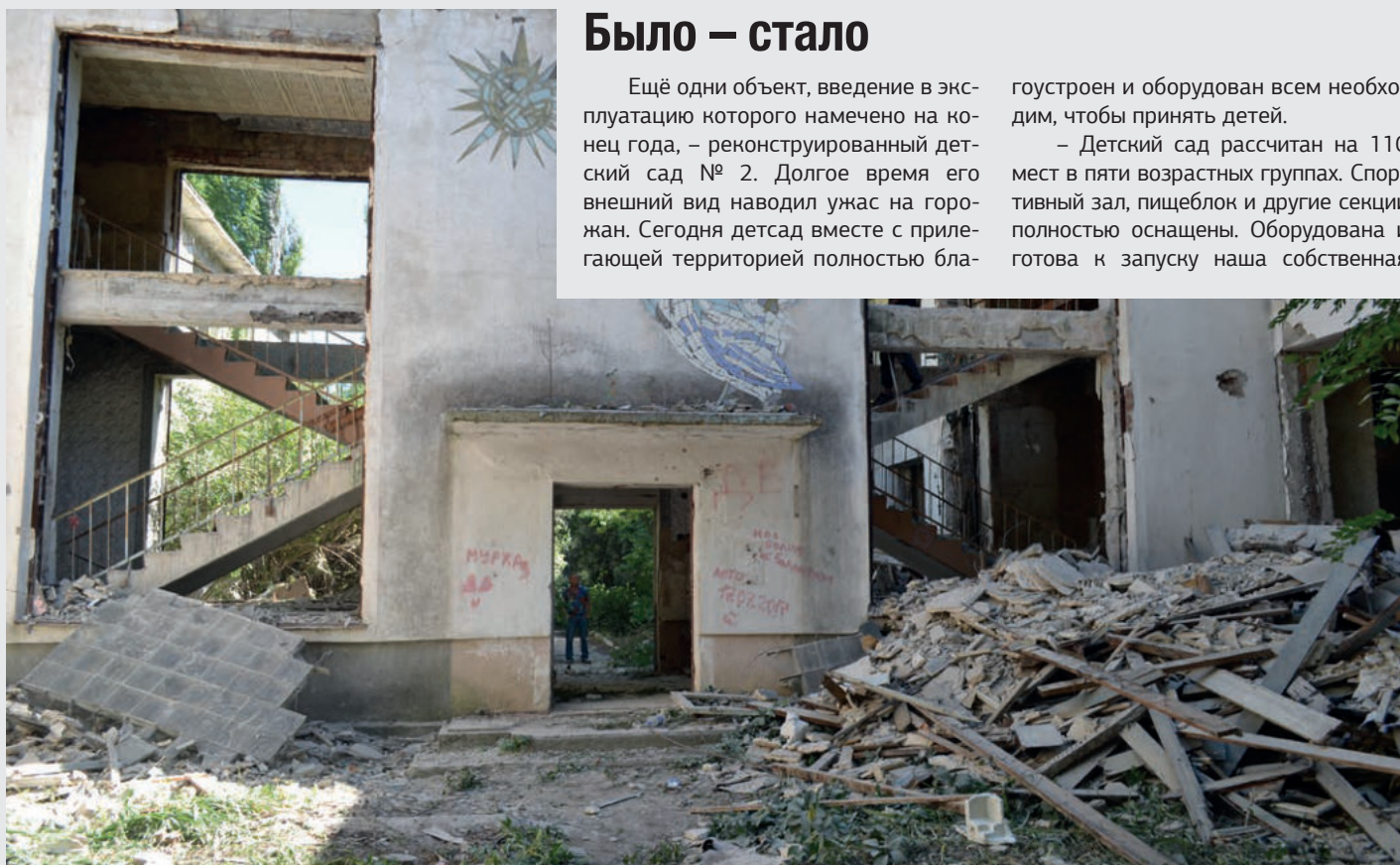
Так выглядело здание детского сада № 2 до реконструкции.
