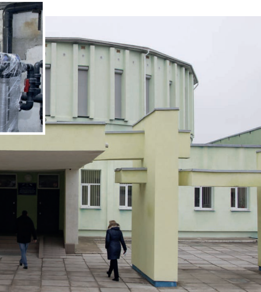
конструируют бассейн. очереди – система вентиляции и климат-контроля.
